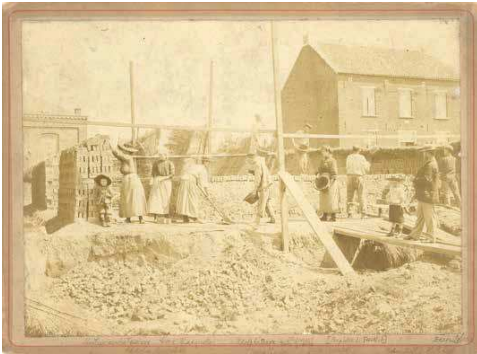
Fabrication de briques pour la construction d'une salle de gymnastique annexée au temple de Courcelles, 1899. © Église protestante de Courcelles
