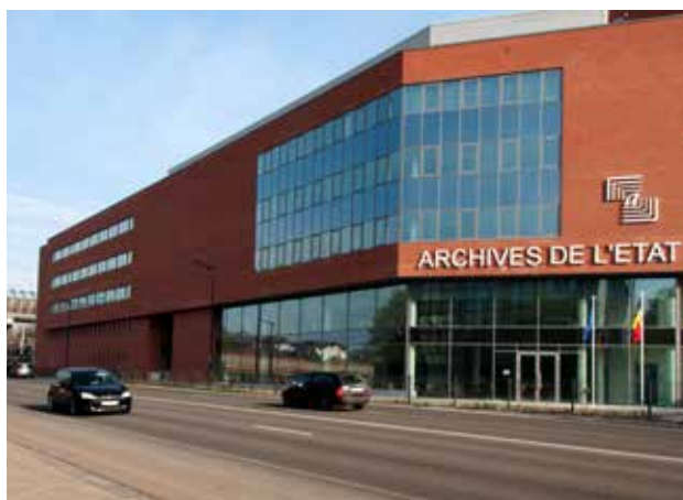
Het nieuwe Rijksarchief Namen aan de boulevard Cauchy. © ARA
