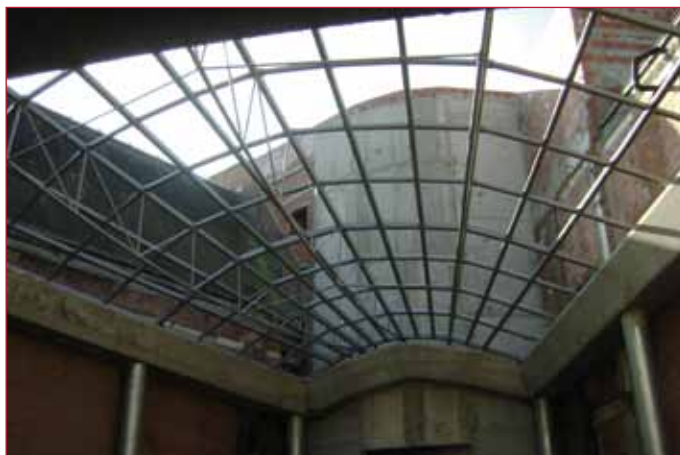
Les travaux aux AÉ à Anvers avancent...lentement
